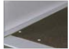
Profils acier protégeant et renforçant le plancher.
